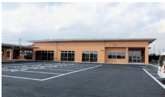
▼妻沼つくし作業所
