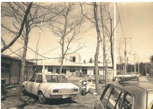
▲建設中の春日園
