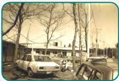
建設中の様子
