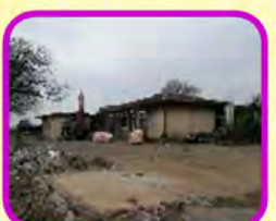
3月1日より、解体工事が始まりました。ここまでこられたのも皆様のお蔭です!
